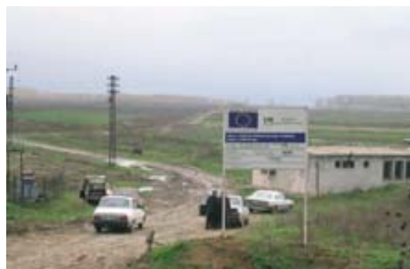
Um projecto ISPA de tratamento de águas residuais na Roménia.
